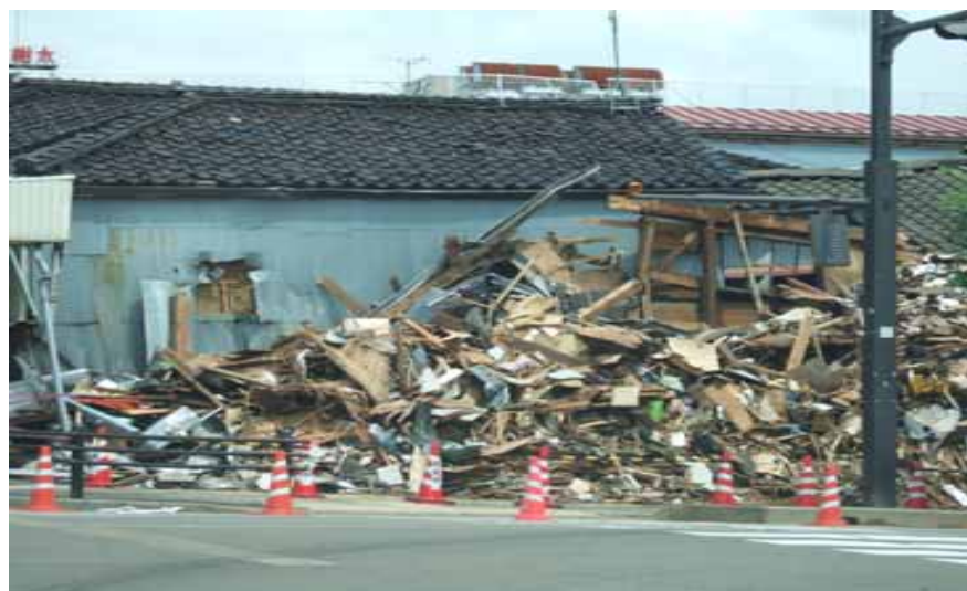
倒壊した家屋
